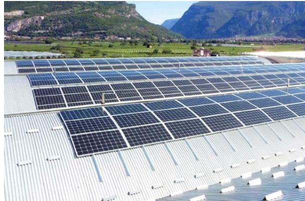
شكل (4-10) الخلايا الشمسية الرقيقة والمرنة واستخدامها في الأسطح المنحنية (Wesoff, 2011)
