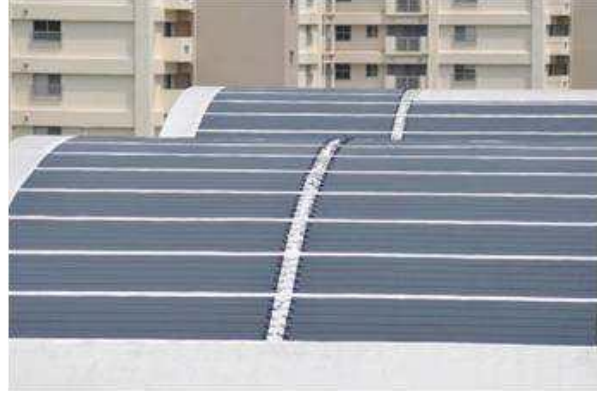
شكل (4-9) الخلايا الشمسية الرقيقة والمرنة واستخدامها في الأسطح المنحنية (Sinaps, Donker, 2013)
