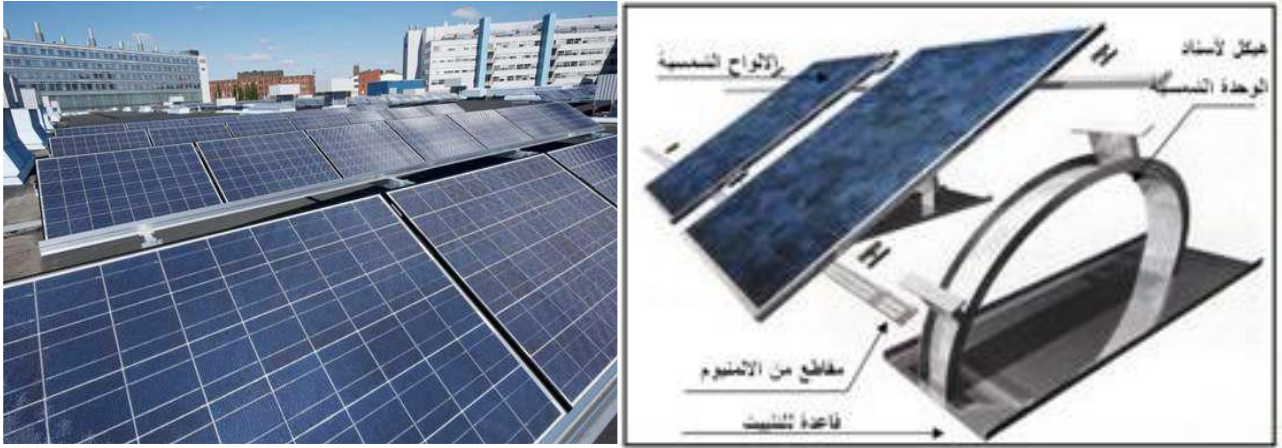
شكل (4-1) الوحدات الشمسية المائلة المصممة للأسطح الأفقية (Sigulda, Latvia, 2010)
