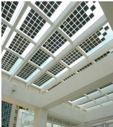
شكل (4-4) استخدام الخلايا الشمسية كأسطح شفافة (Sigulda, Latvia, 2010)
