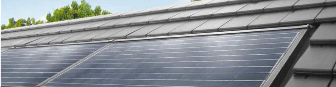
شكل (4-5) الخلايا الشمسية بديل عن مواد الإنهاء التقليدية في الأسطح المائلة (Sinaps, Donker, 2013)
