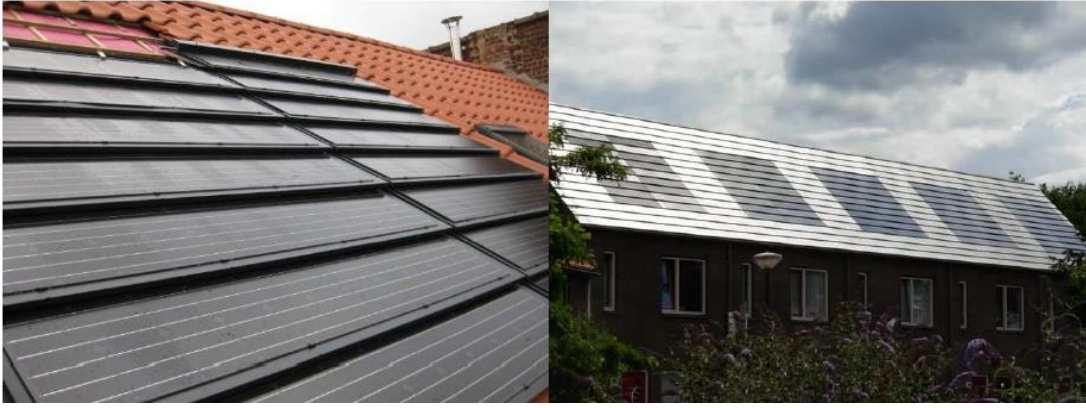
شكل (4-7) الخلايا الشمسية بديل عن مواد الإنهاء التقليدية في الأسطح المائلة وحدات مقواة (Sinaps, Donker, 2013)
